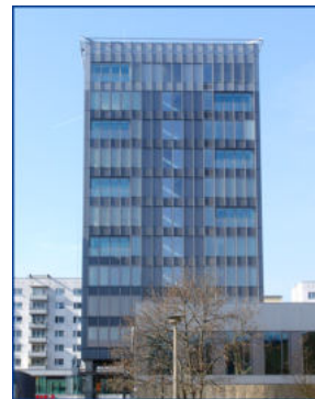
Magdeburg, Katharinenturm 2014 Wohn- u. Geschäfts- haus Rauchschutz-Druck- Anlage Sicherheitstreppenhaus, Feuerwehraufzug 12 Etagen Gebäudehöhe: 46,5 m
