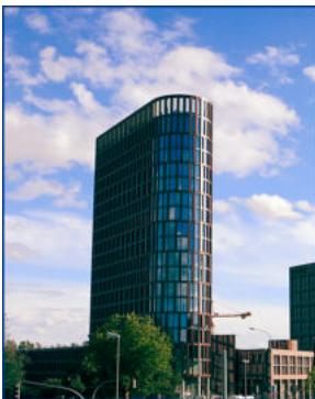
Braunschweig, BraWo-Park 2015 Bürohochhaus Rauchschutz-Druck- Anlage Sicherheitstreppenhaus, Feuerwehraufzug 20 Etagen Gebäudehöhe: 64 m
