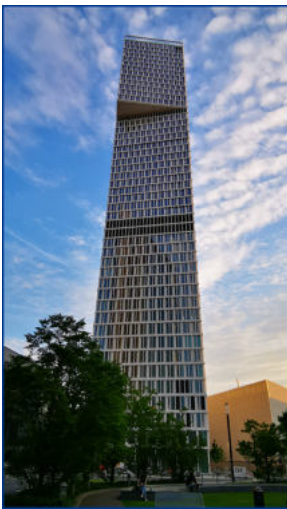
Frankfurt, Tower One 2022 Hotel, Büroturm Rauchschutz-Druck- Anlage Sicherheitstreppenhaus, Feuerwehraufzug 48 Etagen Gebäudehöhe: 191 m
