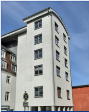
Wolgast, Technisches Rathaus 2022 Rathaus, Bürogebäude Spüllüftungsanlage Treppenhaus
