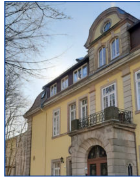
Gersfeld, Schlosspark-Klinik 2020 Klinik Spüllüftungsanlage Treppenhaus
