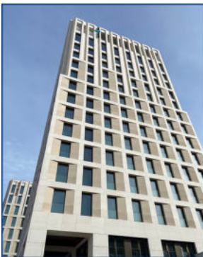
Nürnberg, Tafelhof Palais 2021 Hotelgebäude Rauchschutz-Druck-Anlage Sicherheitstreppenhaus, Feuerwehraufzug 15 Etagen Gebäudehöhe: 50 m
