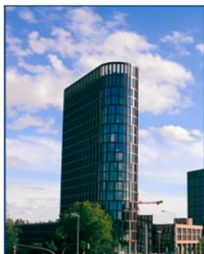
Braunschweig, BraWo-Park 2015 Bürohochhaus Rauchschutz-Druck- Anlage Sicherheitstreppenhaus, Feuerwehraufzug 20 Etagen Gebäudehöhe: 64 m
