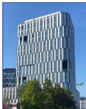
München, Optineo Werksviertel 2023 Verwaltungs- und Bürogebäude Rauchschutz-Druck-Anlage Sicherheitstreppenhaus, Feuerwehraufzug 16 Etagen Gebäudehöhe: 65 m
