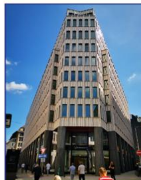
Hamburg, Großer Burstah 2023 Geschäfts- u. Bürogebäude Rauchschutz-Druck-Anlage Sicherheitstreppenhaus, Feuerwehraufzug 9 Etagen Gebäudehöhe: 28 m
