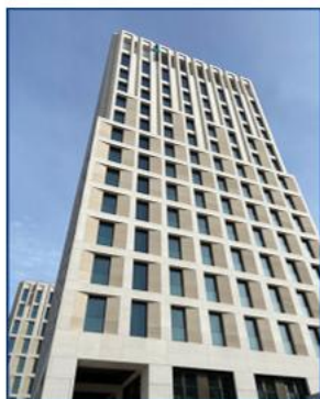
Nürnberg, Tafelhof Palais 2021 Hotelgebäude Rauchschutz-Druck-Anlage Sicherheitstreppenhaus, Feuerwehraufzug 15 Etagen Gebäudehöhe: 50 m
