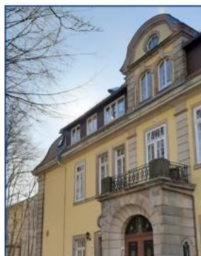
Gersfeld, Schlosspark-Klinik 2020 Klinik Spüllüftungsanlage Treppenhaus
