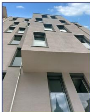
München, Boardinghouse 2025 Studentenwohnheim Spüllüftungsanlage Treppenhaus
